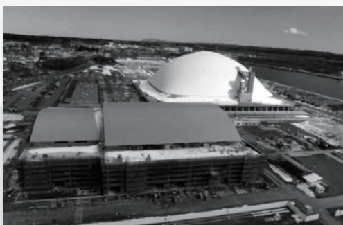
むつ市総合アリーナの工事のようす
