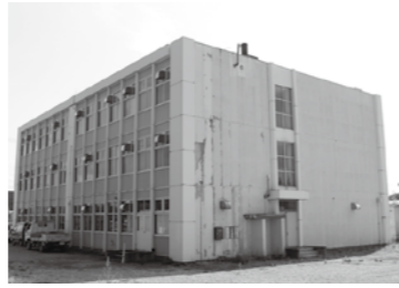
文化財保存施設として活用していく予定の旧庁舎北庁舎
