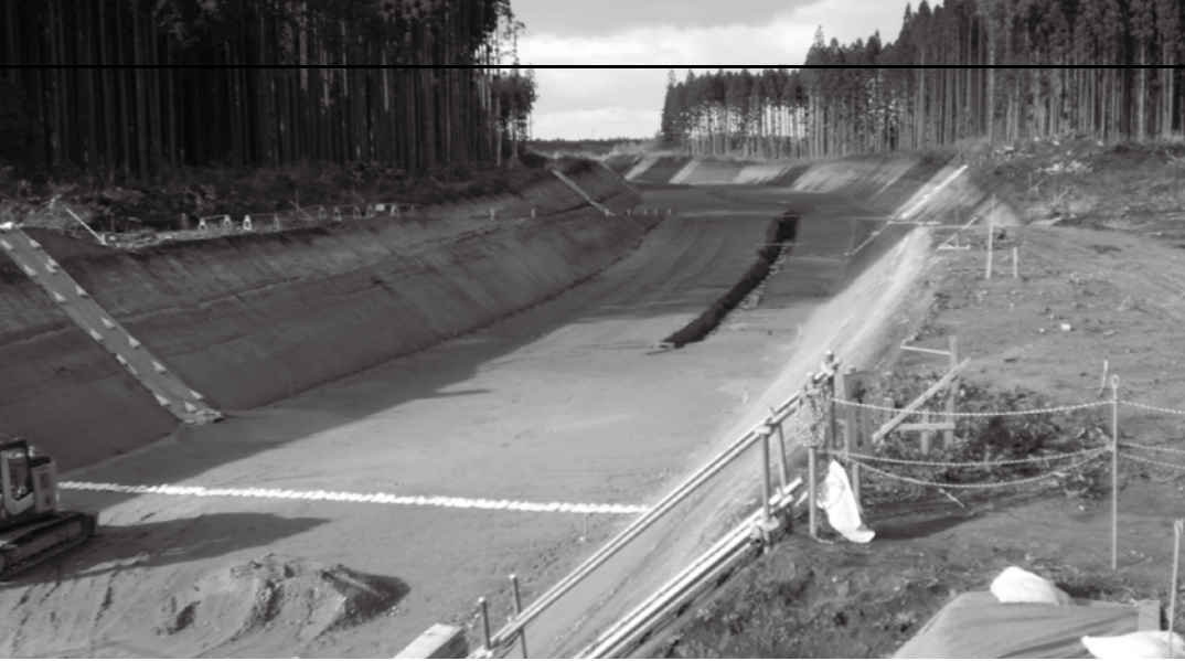
整備が進む「むつ南バイパス」
