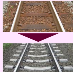
マクラギを木からコンクリートへ
