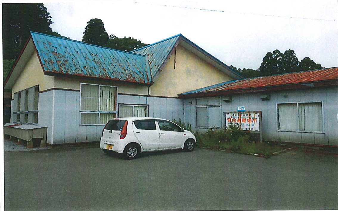
屋根・外壁の状況
