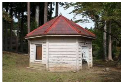
写真③ 国指定重要文化財 乙水槽
