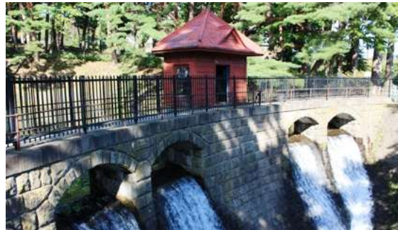
写真① 国指定重要文化財 沈澄池堰堤
