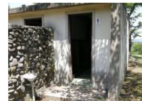
写真⑮ 水源池公園内トイレ
