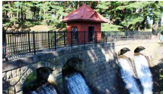
写真① 沈澄池堰堤
