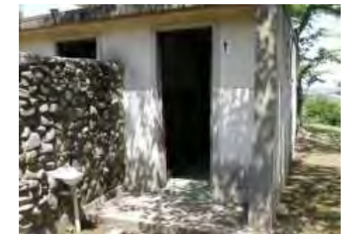
写真⑮ 水源池公園内トイレ
