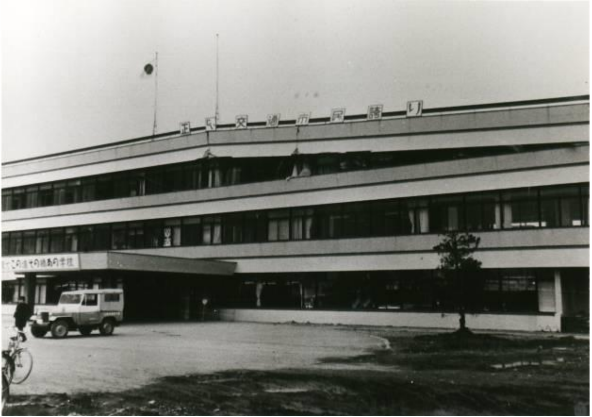
旧むつ市役所の被害
