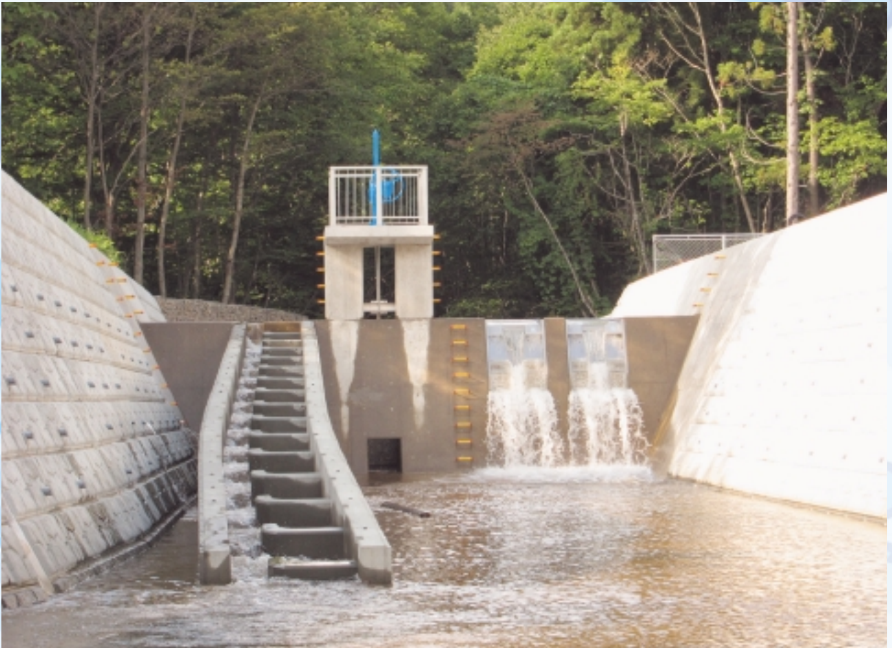
(平成24年に完成した川内地区八木沢取水施設)
