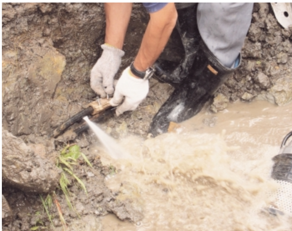
漏水修理工事
