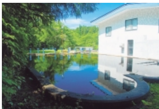
脇野沢浄水場
