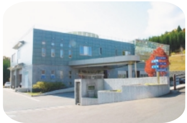
むつ市上水道管理センター
