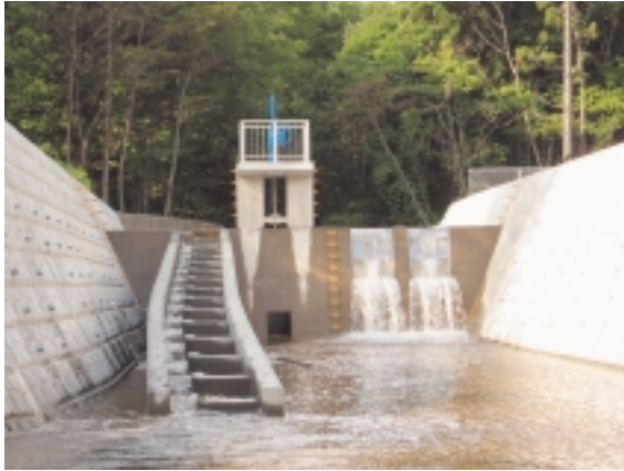
八木沢川取水施設
