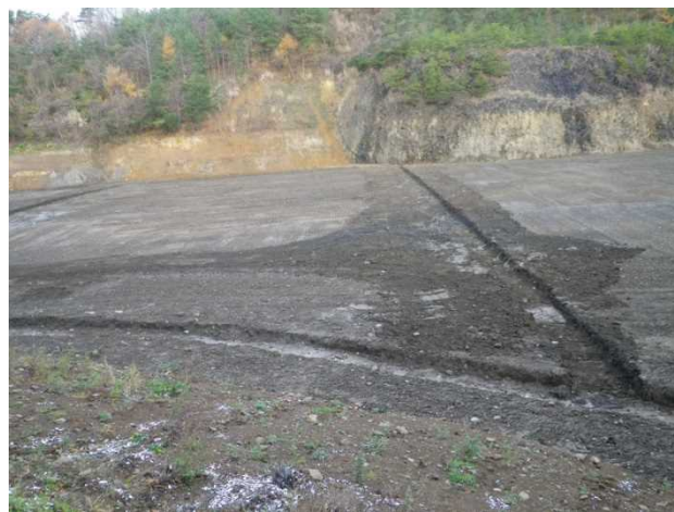
中央部：溝は素掘り側溝
