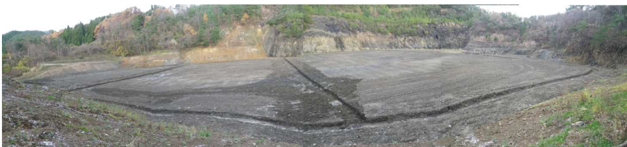
【本工事完了後の現況写真（現場全体を南側斜面から）】
