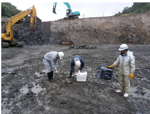
※撤去後の地山土壌の試料採取
