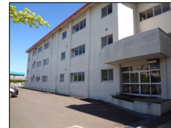
大畑小学校北棟(現況)
