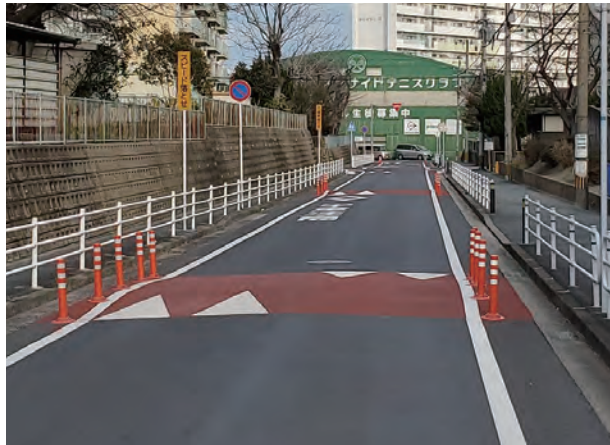
連続ハンブ設置状況 (福岡県北九州市)
