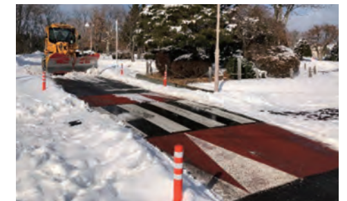
除雪作業の様子
