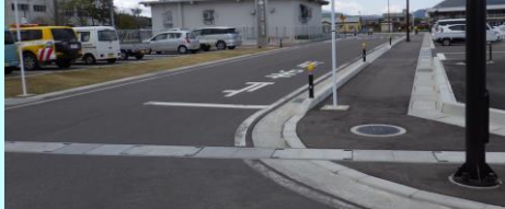
道路(市道伊勢道1号線)
