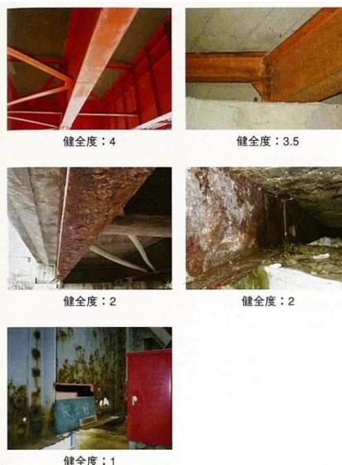
図5-4 健全度評価基準の例(点検ハンドブック)
