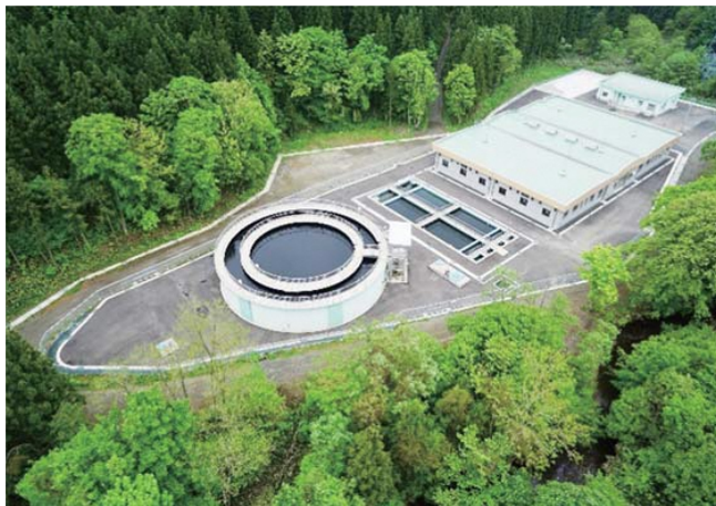
八木沢浄水場
